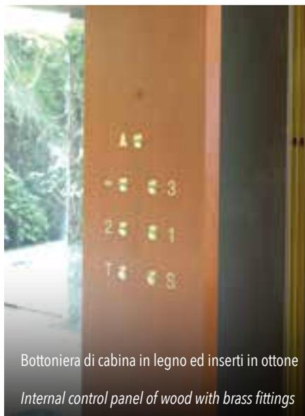
Bottoniera di cabina in legno ed inserti in ottone
