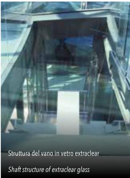
Struttura del vano in vetro extraclear
