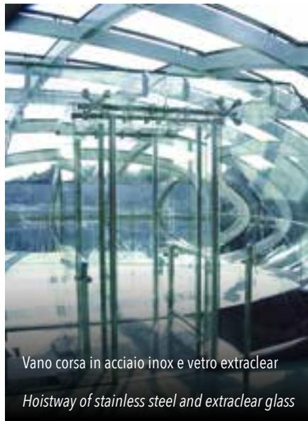
Vano corsa in acciaio inox e vetro extraclear
